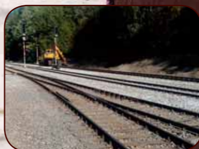
Rekonstrukce žel. stanice Hodkovice nad Mohelkou
