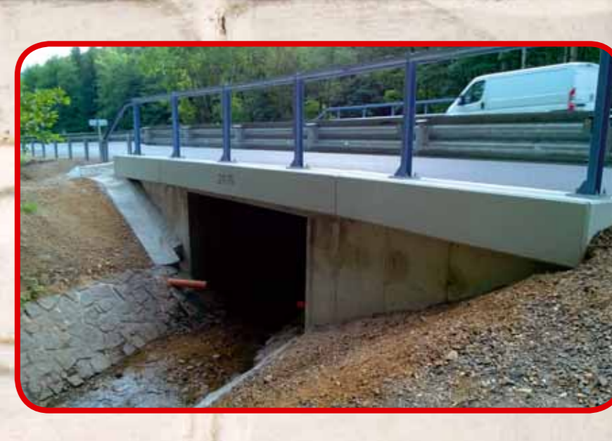
Rekonstrukce mostku v Hůrkách
