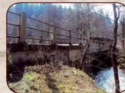
Rekonstrukce mostu v Nových Hamrech
